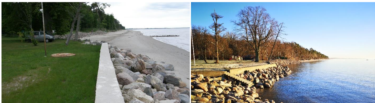
Vaade Valgeranna kohviku eest Pärnu suunas 2009. a (vasakpoolse foto autor: K. Orvik) ja 2021. aastal (parempoolse foto autor: H. Tõnisson). Pärast 2005. a tormi taastati kohvik ja selle kaitseks ehitati võimsam kivimüür. Kohvikust pisut eemal oli veel säilinud madal liivarand. Veidi enam kui kümne aastaga on kivimüüri paljastatud rannast kadunud kogu liiv ja kaitsemüüri ees olev meri on tänaseks umbes 50 cm sügavune. Kivimüüri lõpust Pärnu suunas jätkuvad intensiivsed rannapurustused.
